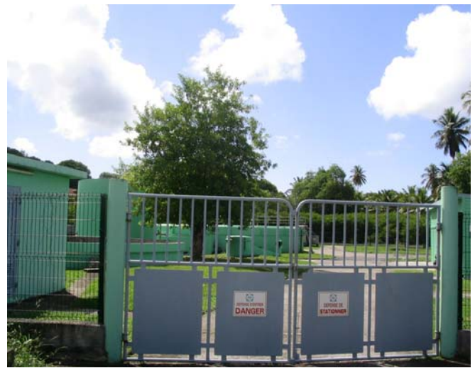
Entrée station du bourg
